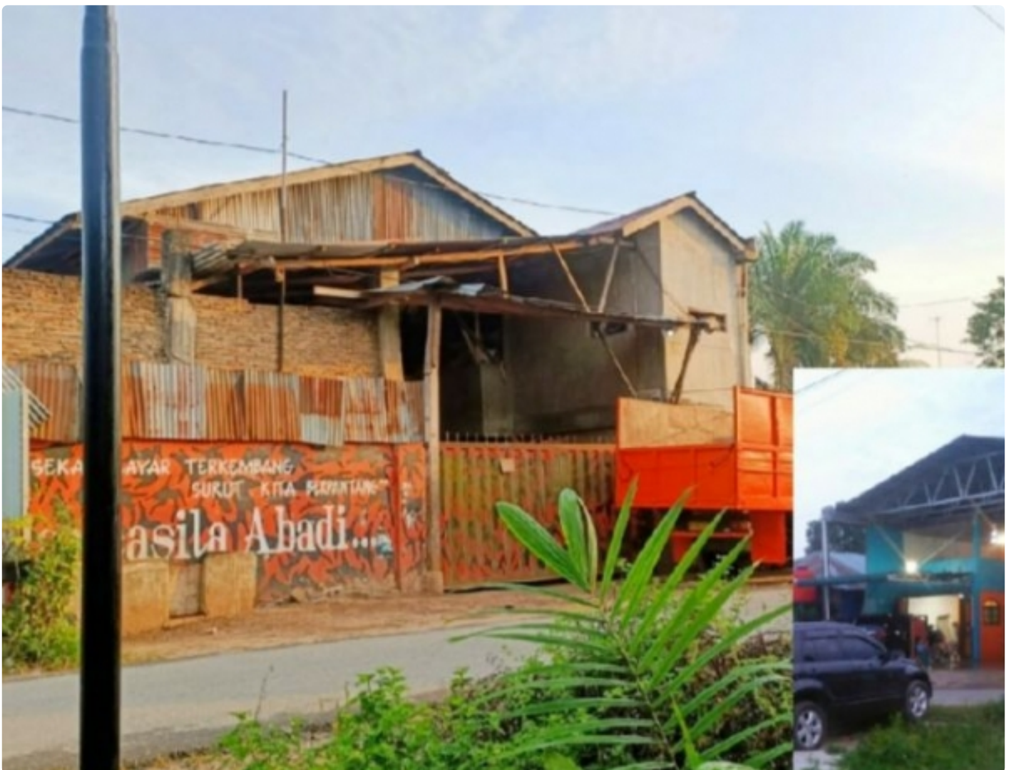
Photo Lokasi Bangunan Baru Dituding Warga Tanpa IMB di Kelurahan Perdagangan III, Kecamatan Bandar, Kabupaten Simalungun
