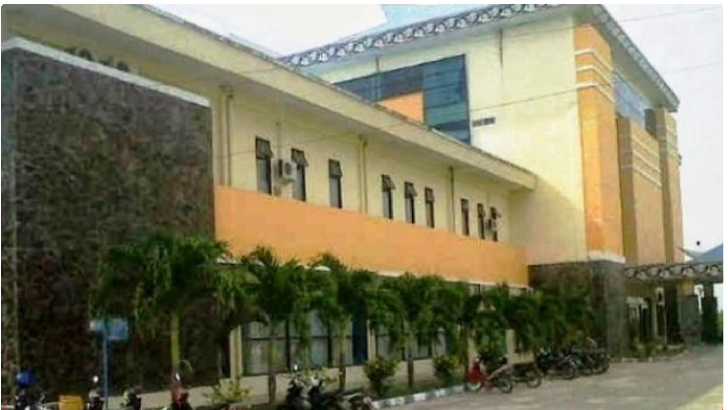
Keterangan Photo : RSUD Perdagangan
