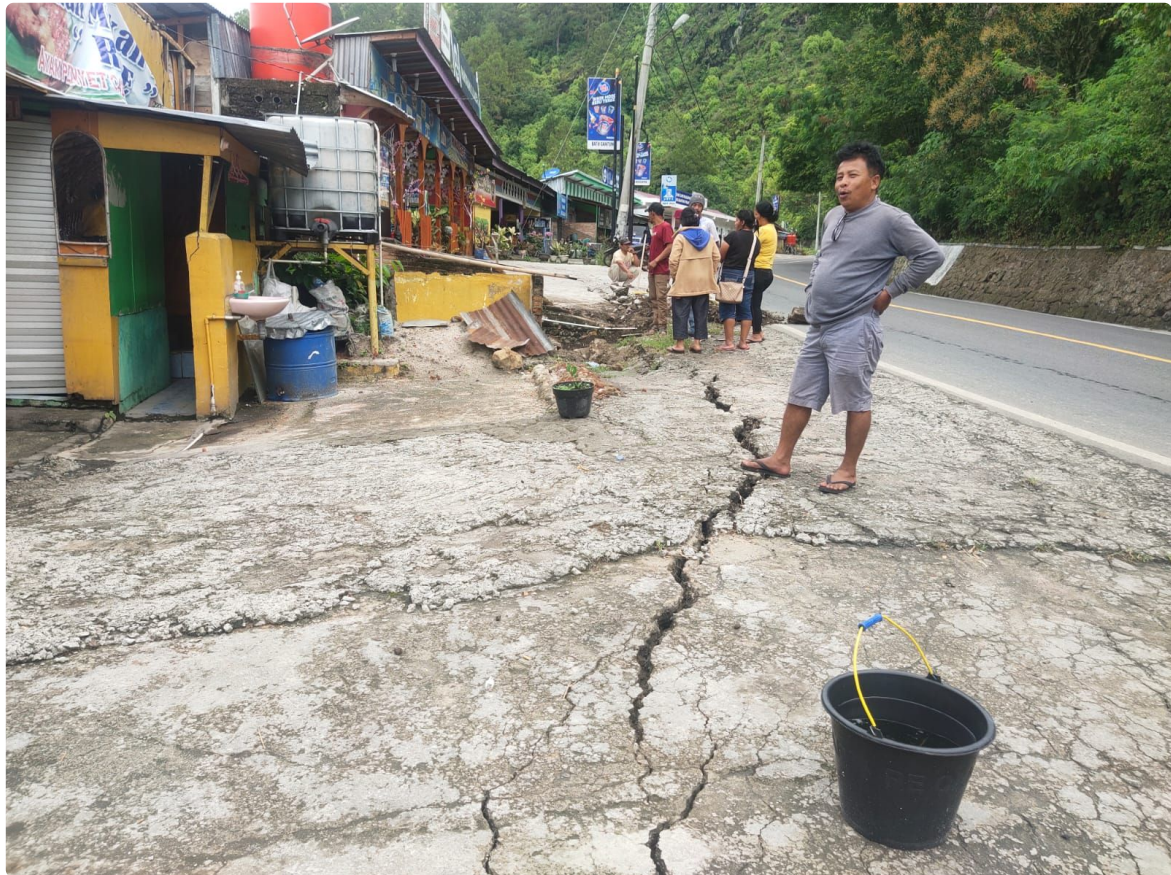
Akibat pergeseran tanah tersebut, satu warung milik J Damanik yang berada ditepi Jalan Lintas Sumatera (Jalinsum) Sibaganding-Parapat nyaris ambruk sementara satu lagi warung milik M Manik mengalami retak-retak dihalaman warung
